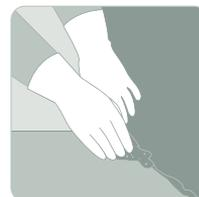
Заполнить штробу составом, **тщательно уплотнить** вручную.
